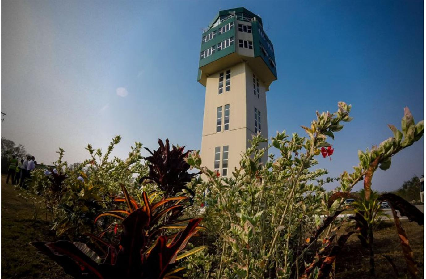
La nueva estructura, con una altura total de más de 30 metros hasta la cubierta, y un mástil de seis, para las antenas de los equipos de comunicación y pararrayos, ofrece a los controladores aéreos, ubicados a 28 metros, una visual de 360 grados, con mucho más confort y amplitud que la anterior instalación. Foto: Juan Pablo Carreras.
