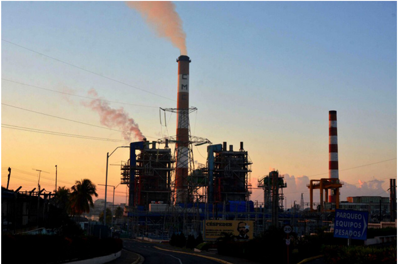
Termoeléctrica de Cienfuegos.
