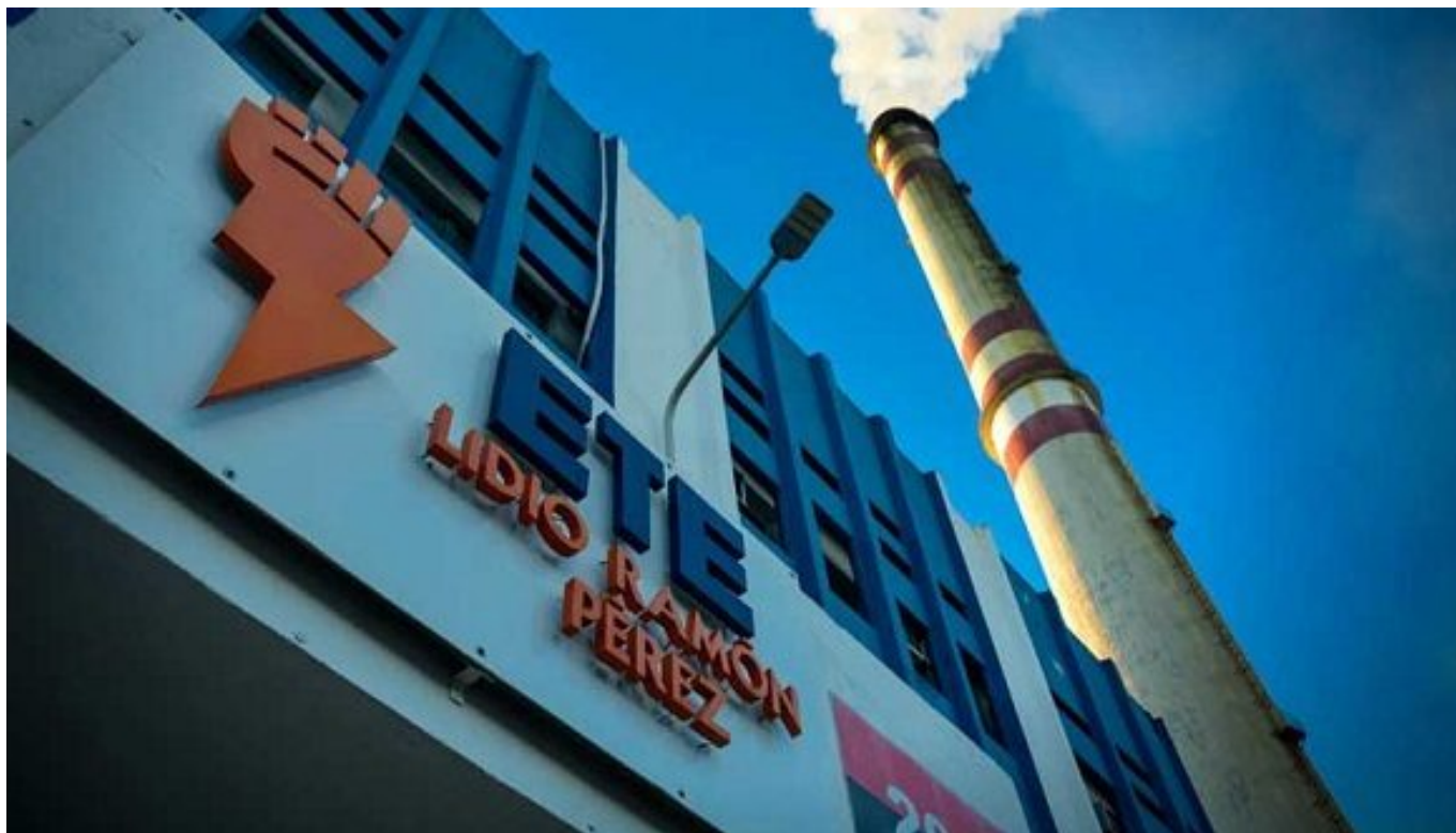
Termoeléctrica Felton. Foto: Archivo.
